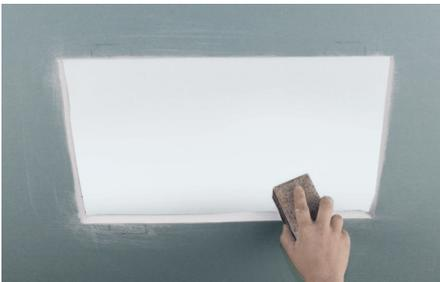
1.4 Öffnung mit Schleifpapier glätten ( Körnung 100 - 150 ). Hochstehende Teile des Deckpapiers entfernen.
