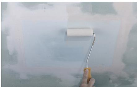
**1.15** Den mitgelieferten Kleber (Ovalit S, mit 20 % Wasser verdünnt) mit einer Schaumstoffrolle auf die Membrane und die Fläche ringsum mit wenig Druck gleichmäßig auftragen.
