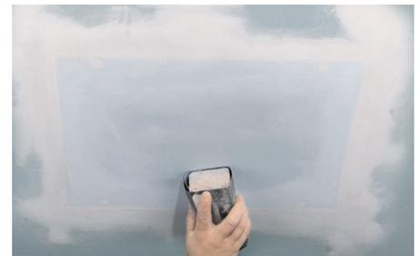
**1.14** Die Hartschaum-Membrane darf nur am Rand mit wenig Druck geschliffen werden, auf der Membrane soll keine Spachtelmasse verbleiben.
