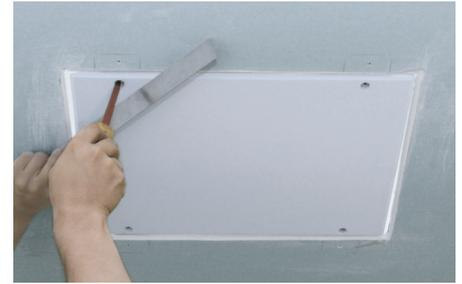
**1.11** Lautsprecher mit den Befestigungsschrauben so justieren, dass die Hartschaum-Membrane gleichmäßig ca. 0,5 bis 1 mm übersteht.
