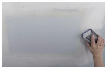
**1.19 WICHTIG** Vor dem Überstreichen sicherstellen, dass die Spachtelmasse komplett durchgetrocknet ist (am besten über Nacht), sonst ist eine sichere Haftung der Farbe nicht gewährleistet.
