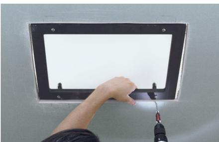
1.6 Montage-Füße verschrauben ( von vorne mit Trockenbau-Schrauben durch die Gipskarton-Platte in die Montage-Füße schrauben ).
