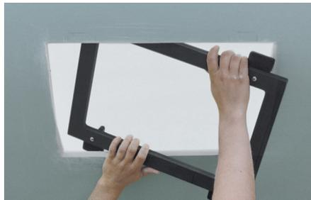
1.5 Montage-Rahmen mit Montage-Füßen einsetzen.
