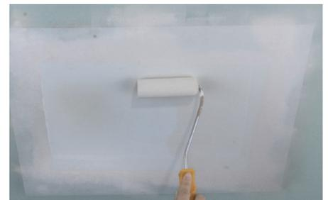
**1.17** Das Vlies mit der Rolle und wenig Kleber nochmal überstreichen und glattwalzen. **Danach den Klebstoff komplett durchtrocknen lassen (über Nacht).**
