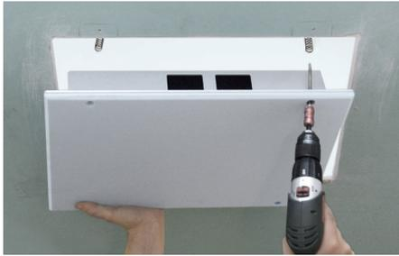
**1.9** Lautsprechersystem verschrauben. **(Am Besten zu zweit!)** Alleine: Den Lautsprecher an einer Ecke mit Schraube auf Magnetbit führen und verschrauben.
