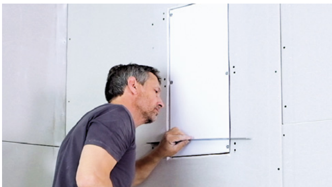
Lautsprecher flächenbündig justieren.
