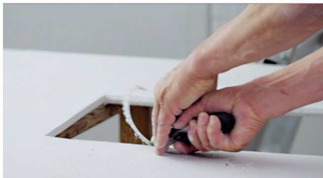
Kanten der Einbauöffnung anschrägen...
