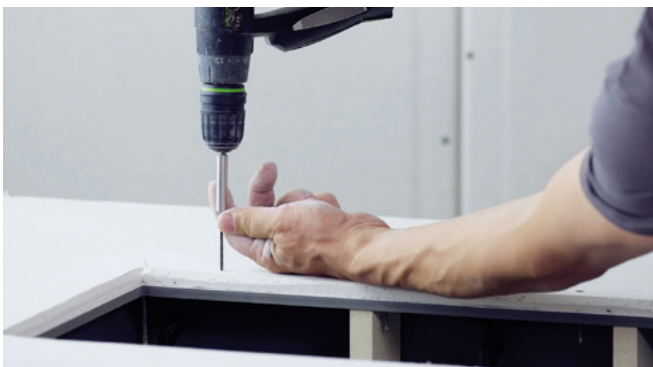
Gehäuse ringsum mit der GK-Platte verschrauben.
