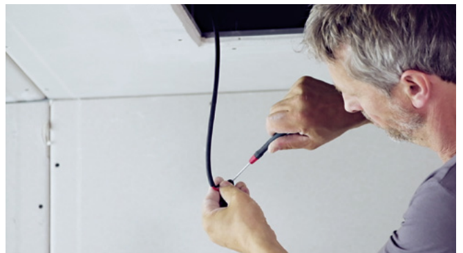
Systemklemme an Lautsprecherkabel montieren.
