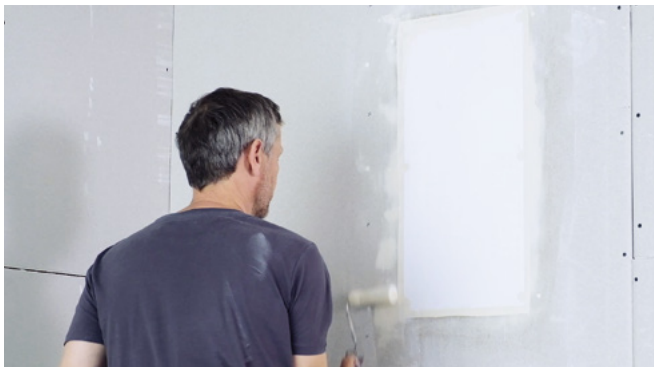
Kleber gleichmäßig auftragen.
