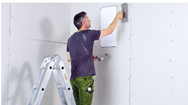
Übergänge und Schraubenlöcher 2 x spachteln.
