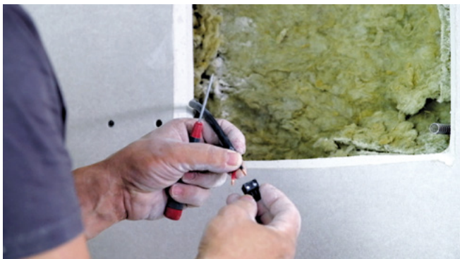
Systemklemme an Lautsprecherkabel montieren. Auf richtige Polarität achten.
