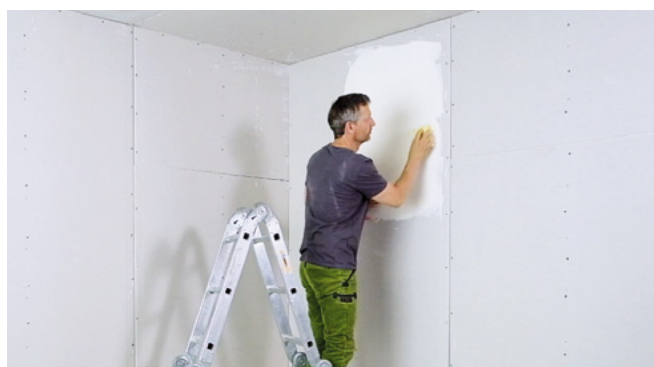
Gesamte Fläche schleifen. Auf der Membran mit wenig Druck.
