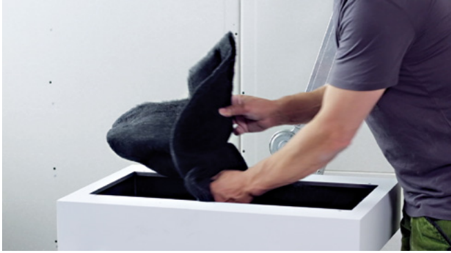
Die lose Dämmwolle aus dem Gehäuse entfernen.
