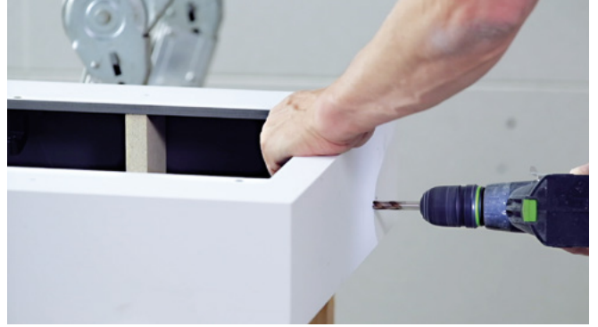
Gehäuse mit Bohrung für Zuleitung versehen.
