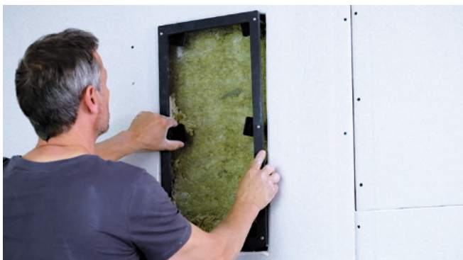
Montagefüße mit Rahmen einsetzen...
