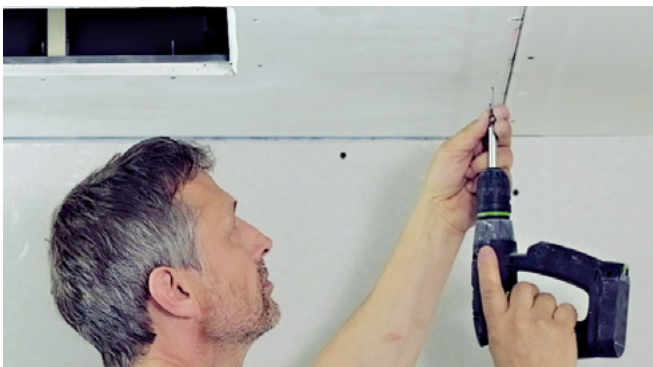
und GK-Platte in der Decke verschrauben.
