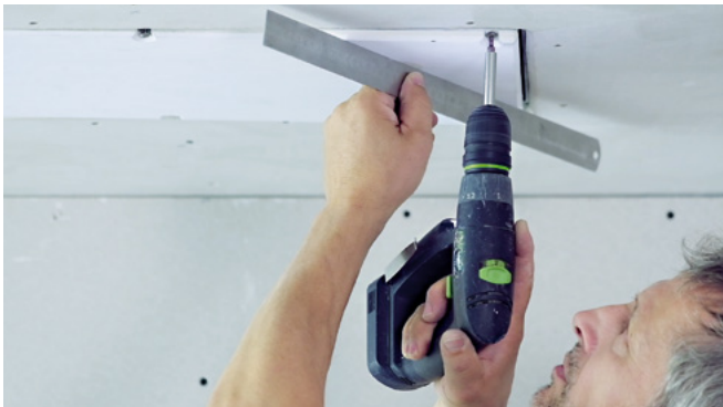
Lautsprecher komplett verschrauben und flächenbündig justieren. Alle Schrauben müssen auf Spannung sitzen.
