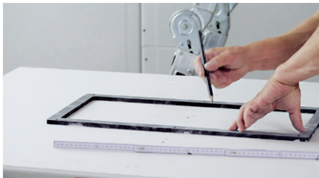
Einbauposition festlegen und Ausschnitt anzeichnen.
