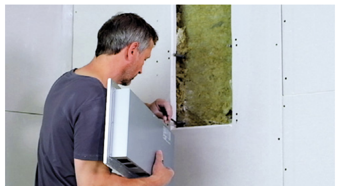
Lautsprecher anschließen. Kabel mit Kabelbinder zugentlasten.
